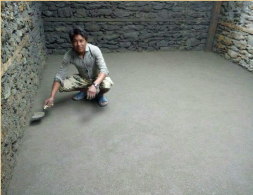
Les travaux de finitions de la dalle
