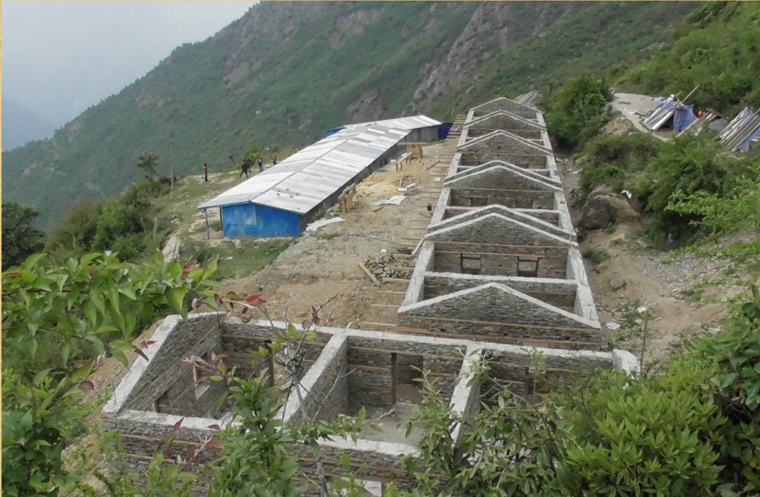
Vue d'ensemble de la fin des murs
