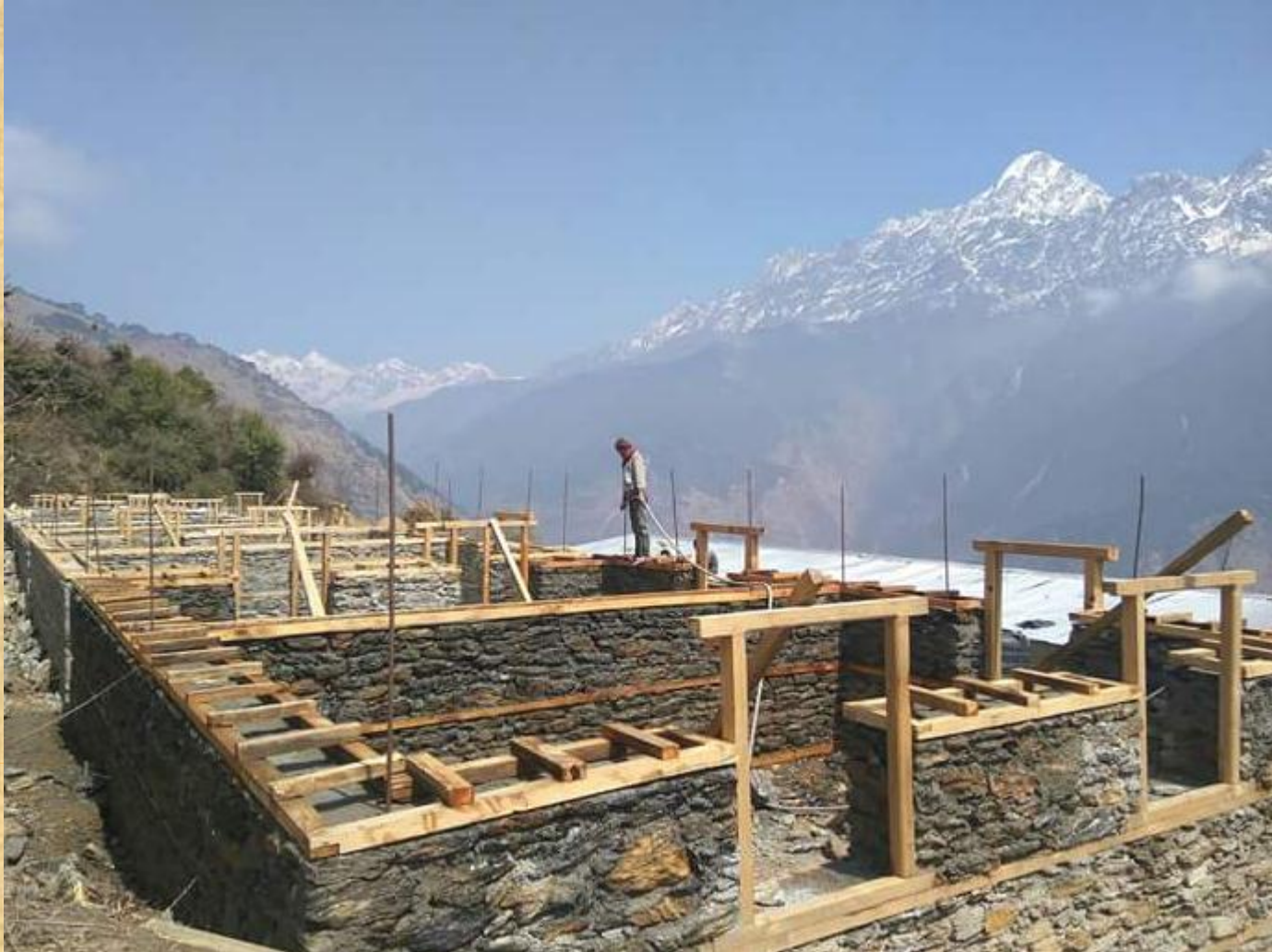
Montage des murs en cours
