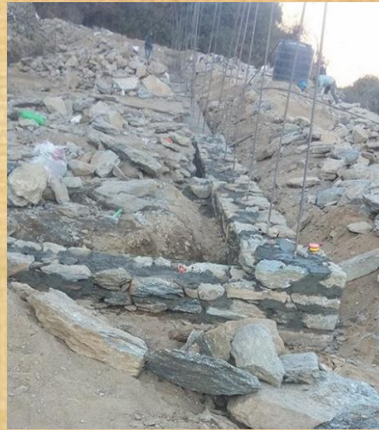
Barres d'aciers en renfort de la maçonnerie
