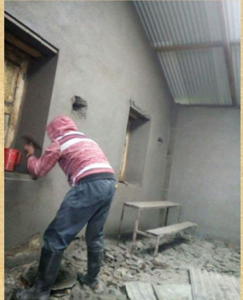
Les travaux associées au crépis avant peinture
