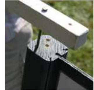
**4 - Fixer la toile** grâce au velcro positionné sur le tasseau
