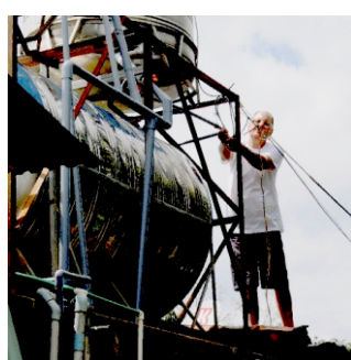
Je pose les contacteurs de niveau ans les réservoirs
