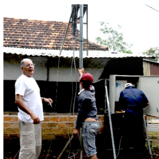
le réseau électrique est en cours de montage
