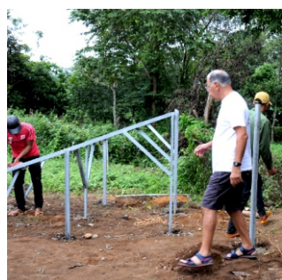
Les supports de panneaux solaires sont en cours de scellement
